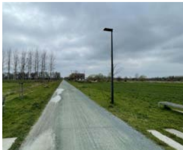
Een wandel- en fietsverbinding langs de Abelestationstraat ©Stijn De Roo via https://www.nieuwsblad.be/cnt/dmf20230403_94636605
