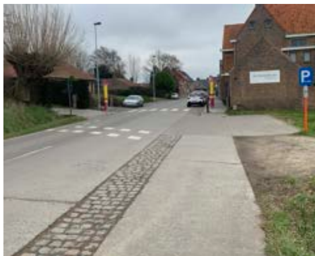
Trappistenweg - Een niet reglementair fietspad tot aan het begin van het dorp
